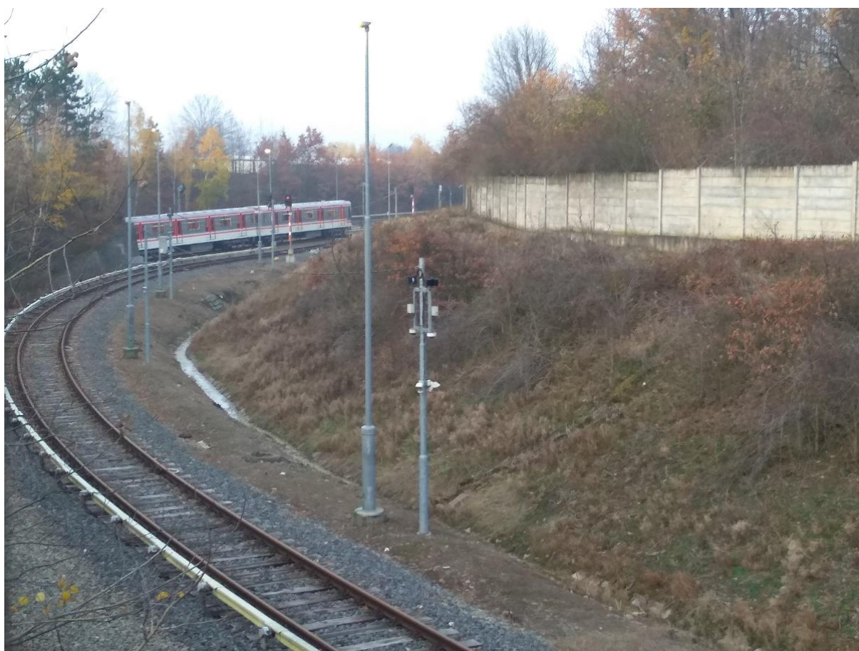
Obr. 4 Povrchový úsek metra s jedoucím vlakem – Praha u Depa Hostivař
