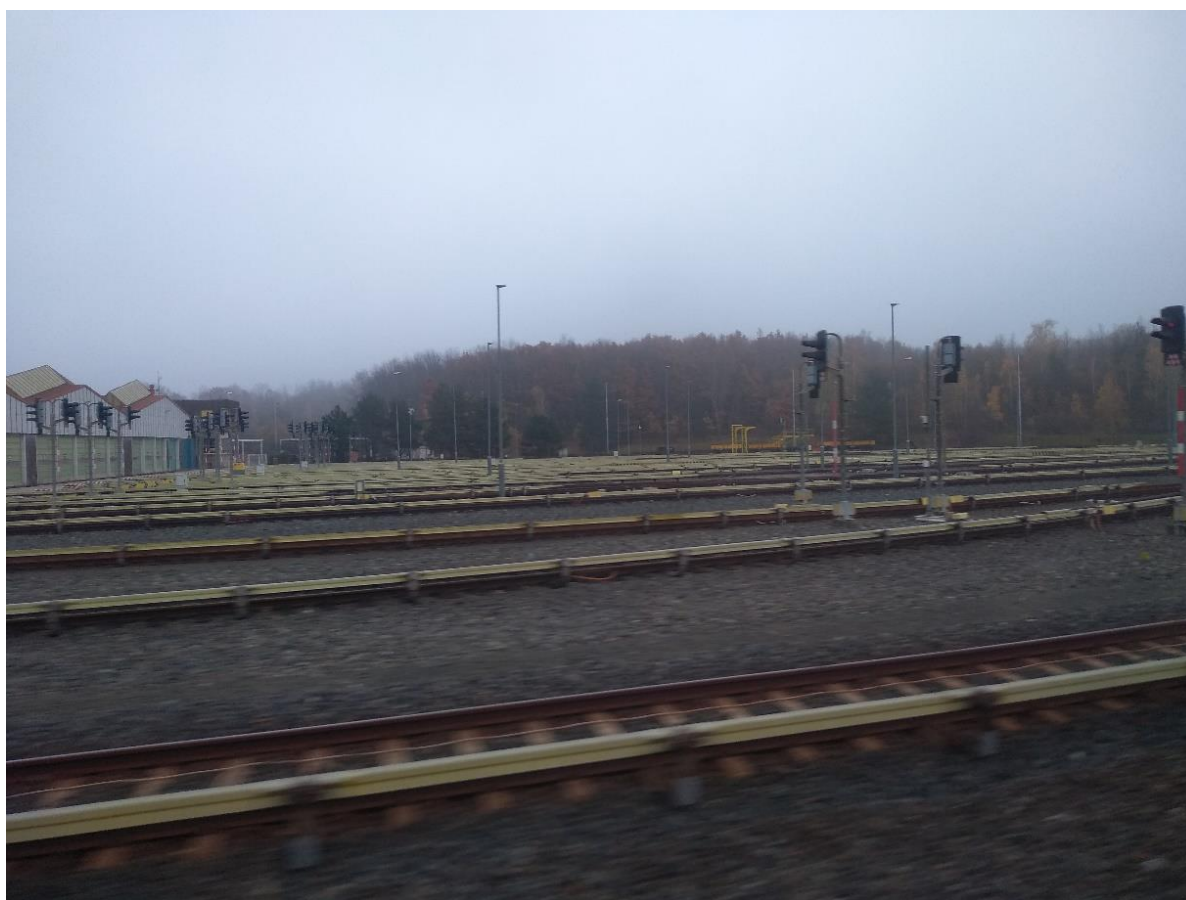
Obr. 5 Koleje s napájecí třetí kolejnicí – Praha Depo Hostivař
