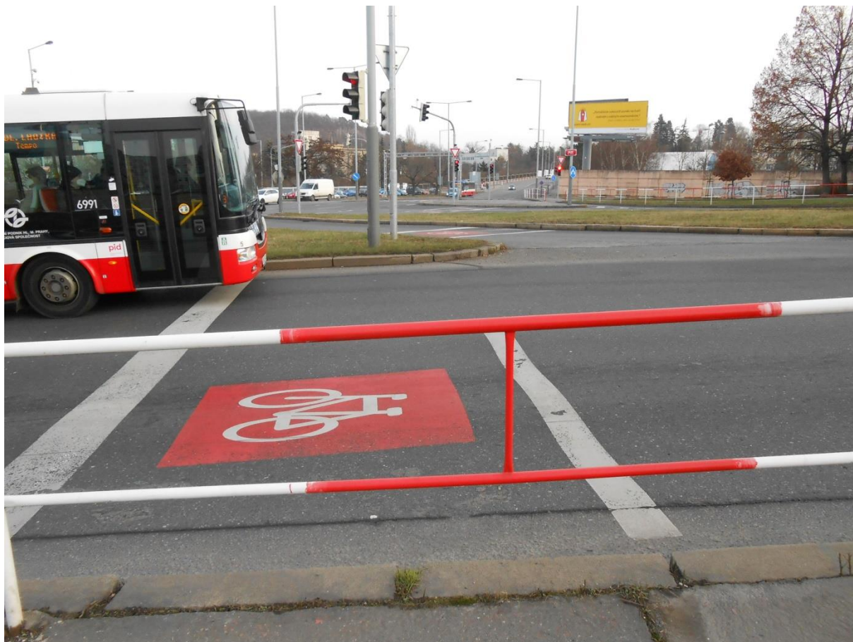
Obr. 5 Předsunutá stopčára – Praha, Vídeňská ulice
