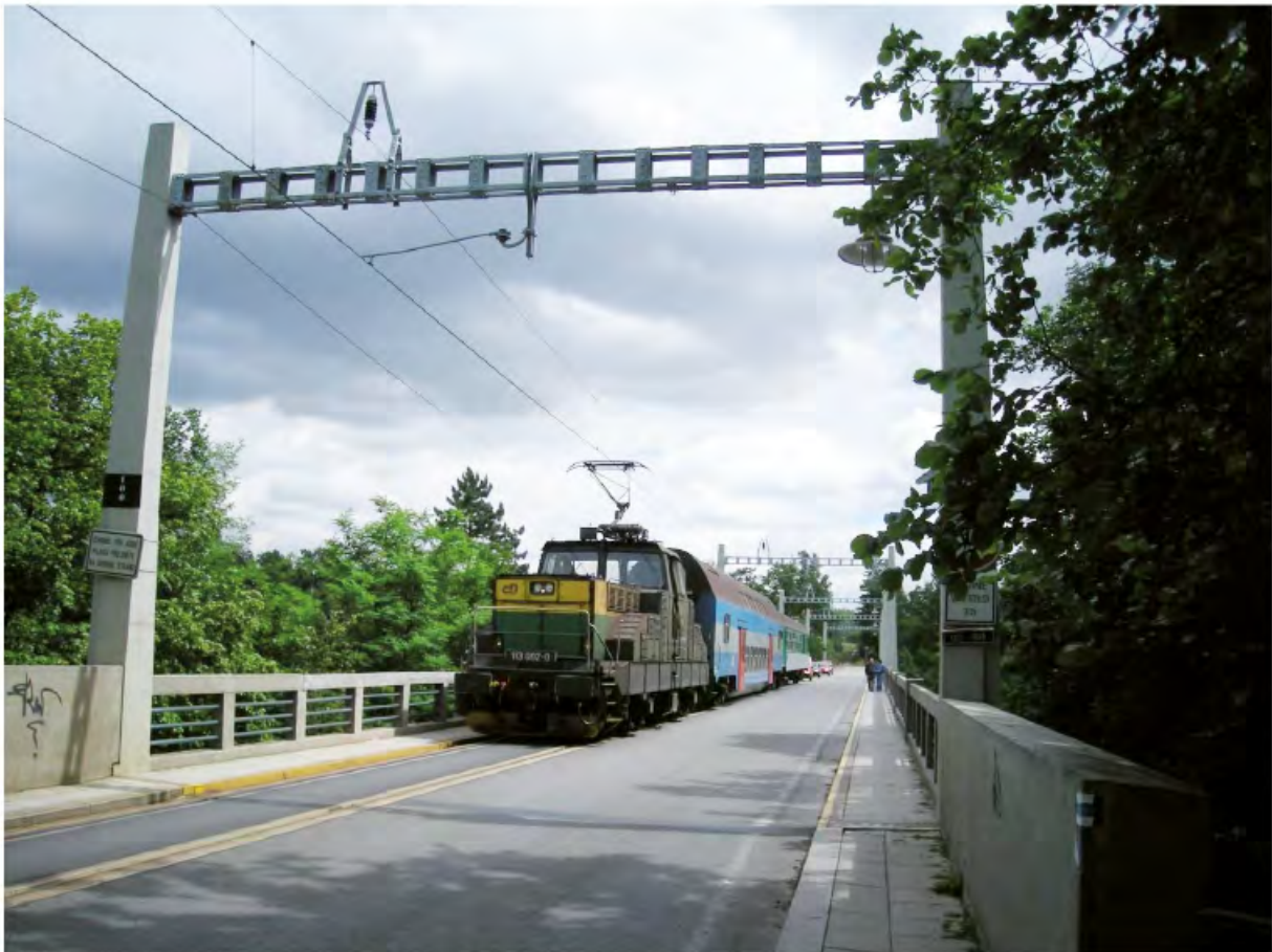
Obr. 21 Silniční přejezd na mostě Duha v Bechyni
