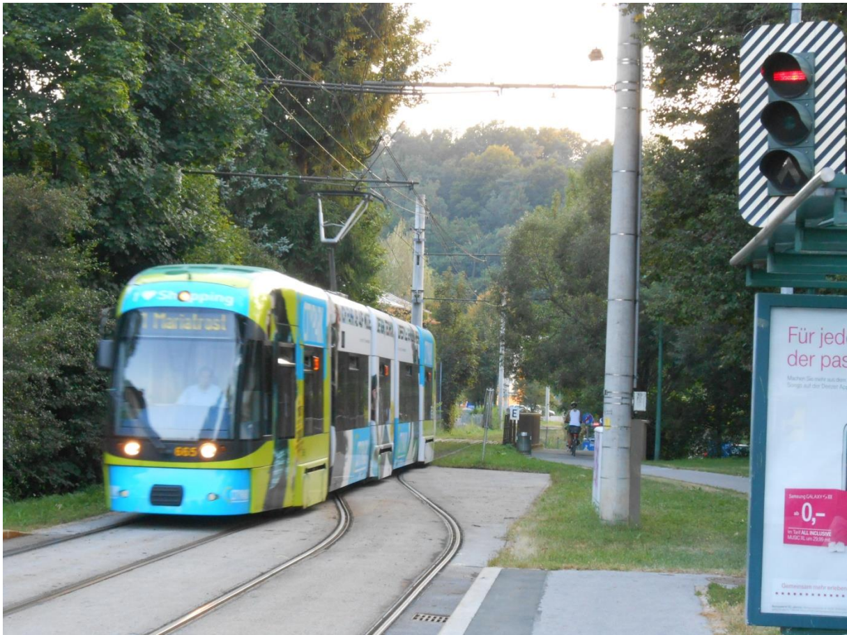
Obr. 18 Jednokolejná tramvajová trať se zabezpečením – Rakousko, Graz, Mariatrost
