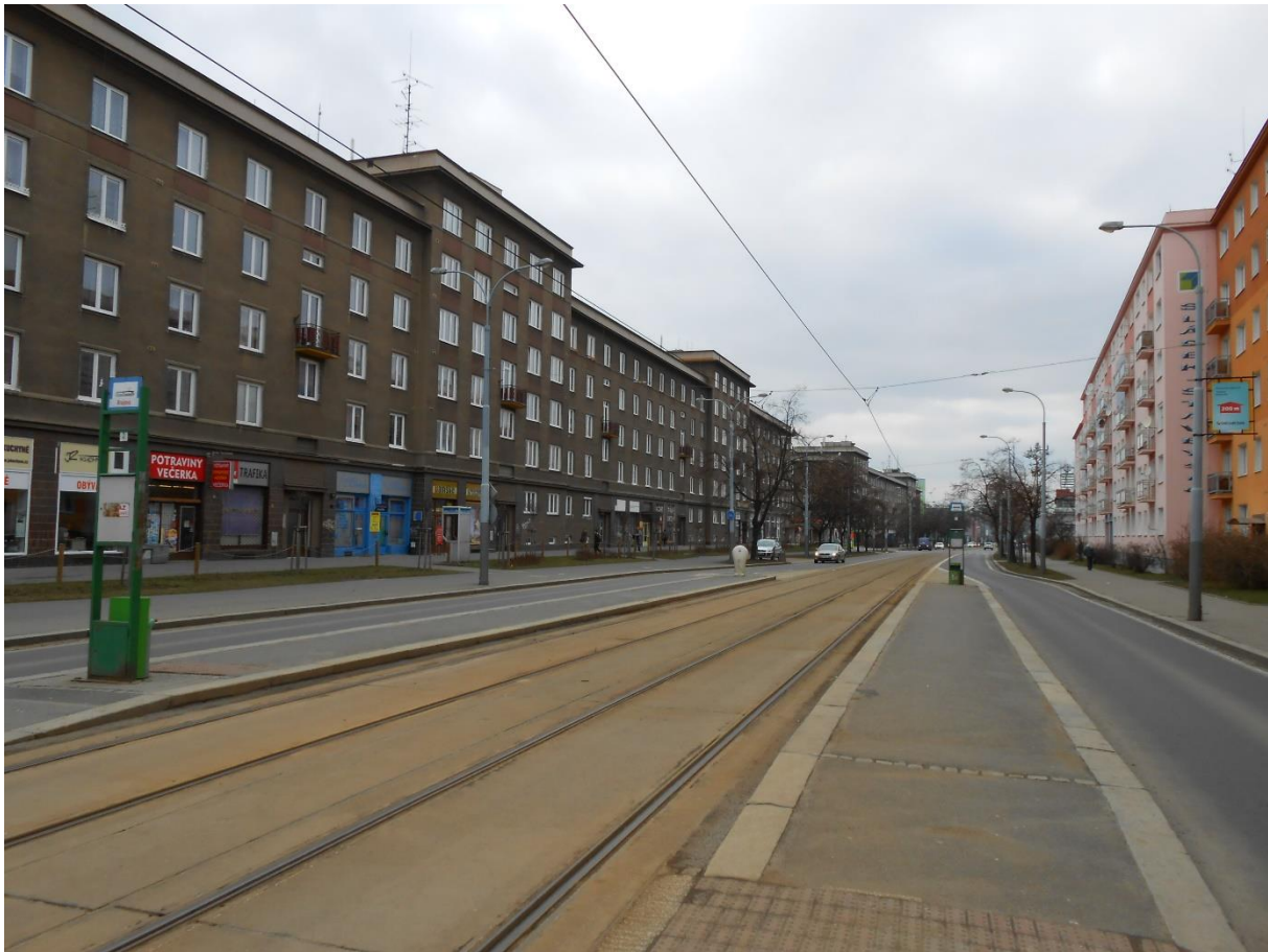
Obr.31 Klasické vedení tramvajové tratě, Plzeň-Brojova
