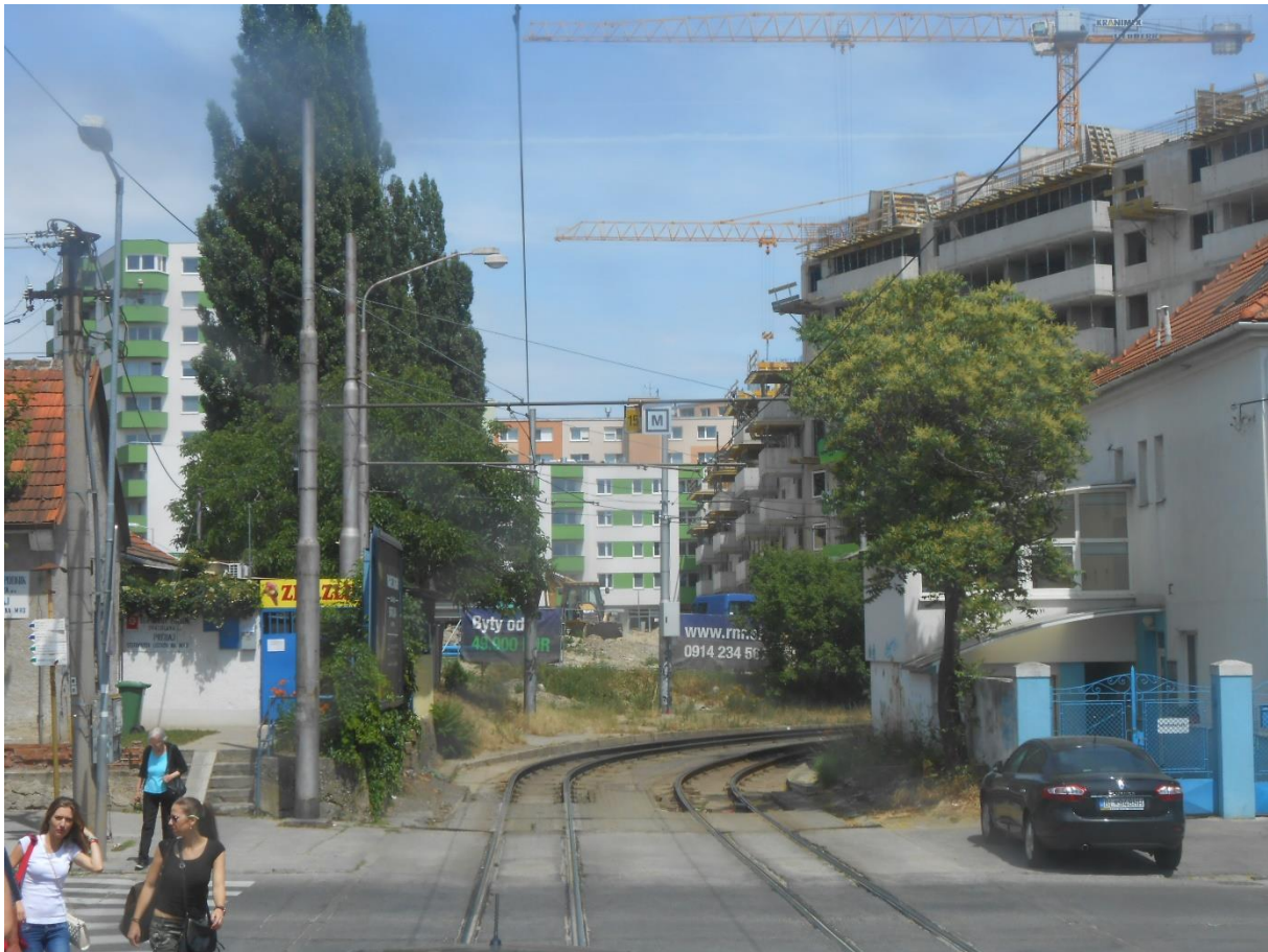
Obr.35 Přečhod tramvajové trati z uličního prostoru na vlastní těleso, Bratislava, Rača
