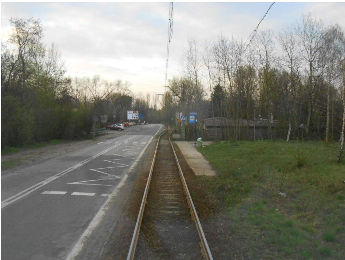
Obr.21 Zastávkový prostor umístěný v protisměrném jízdním pruhu, Katowice, Sosnowiec (původní podoba tratě, dnes zdvojkolejněno a trať integrována do silnice)
