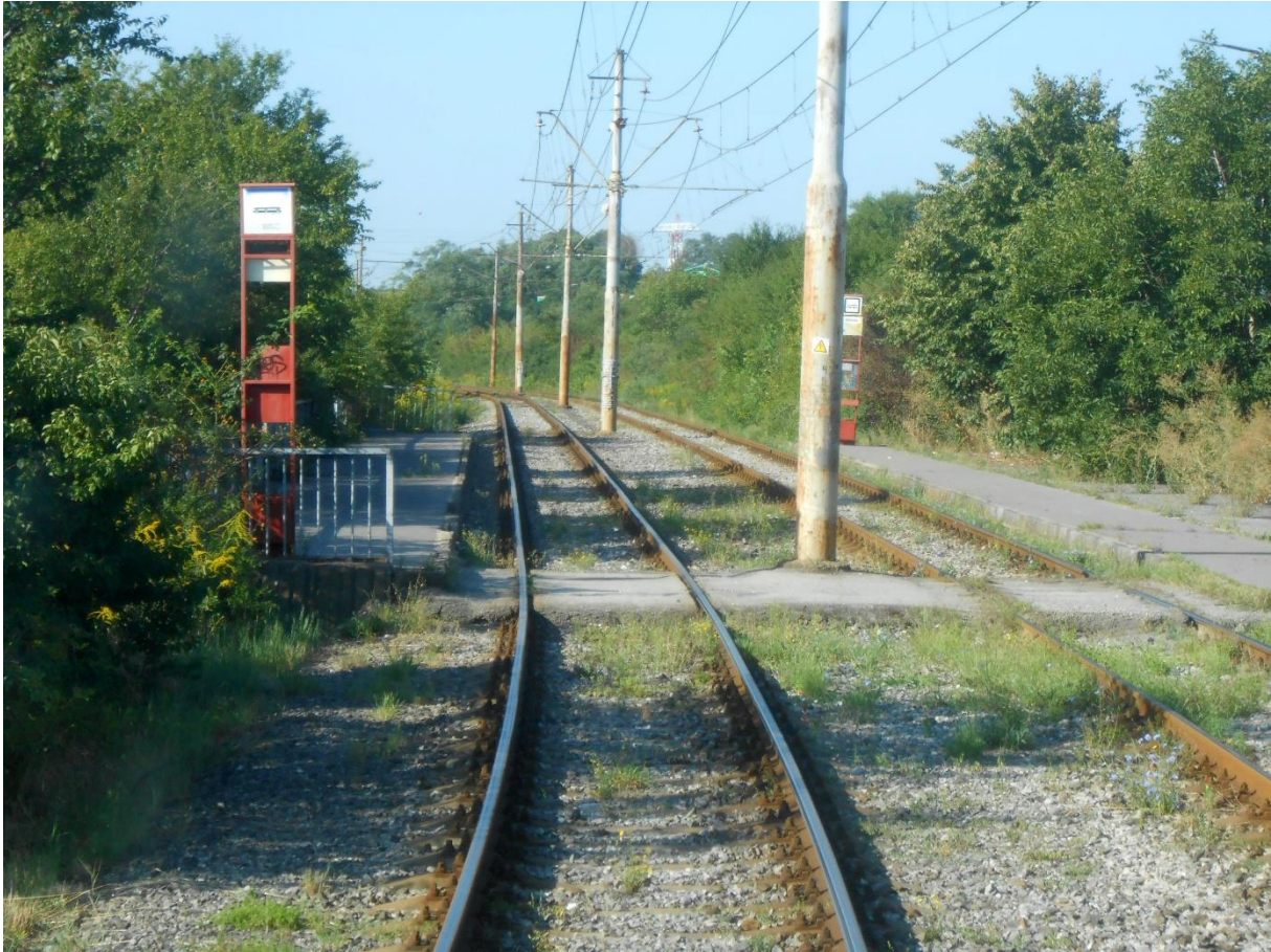
Obr.36 Trať k železárnám, Košice-Perešská
