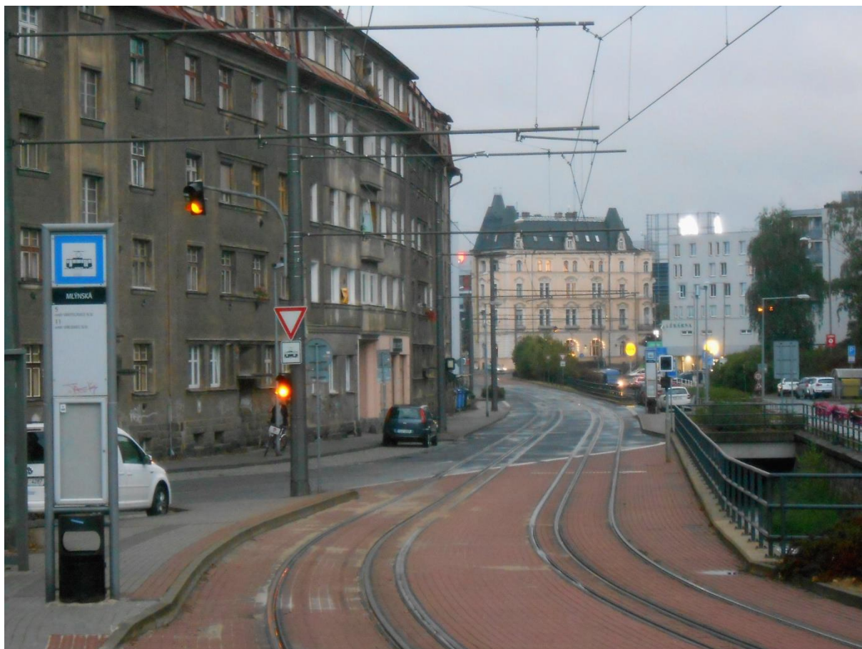
Obr.1 Trať se dvěma rozchody (1000 a 1435 mm), Liberec-Mlýnská
