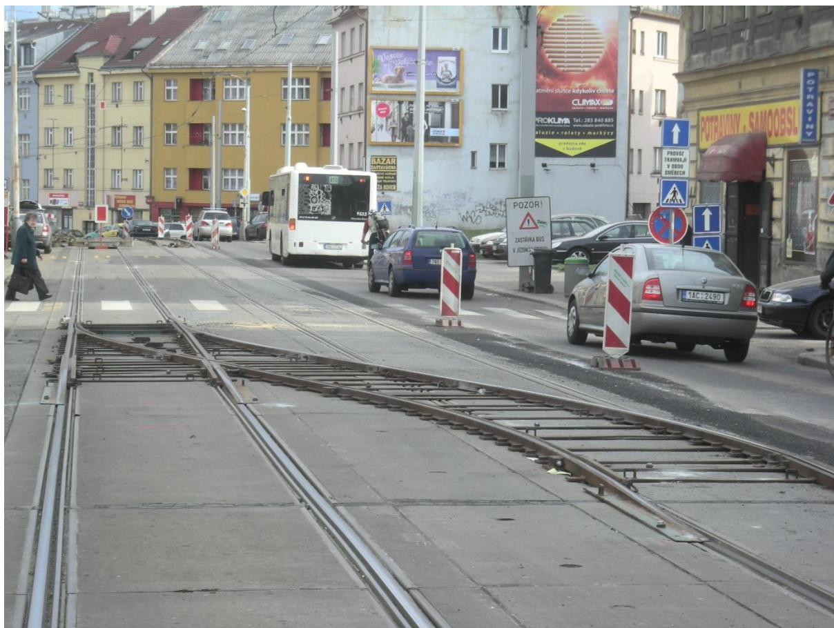
Obr.13 Dočasný kolejový přejezd, Praha-Vosmíkových
