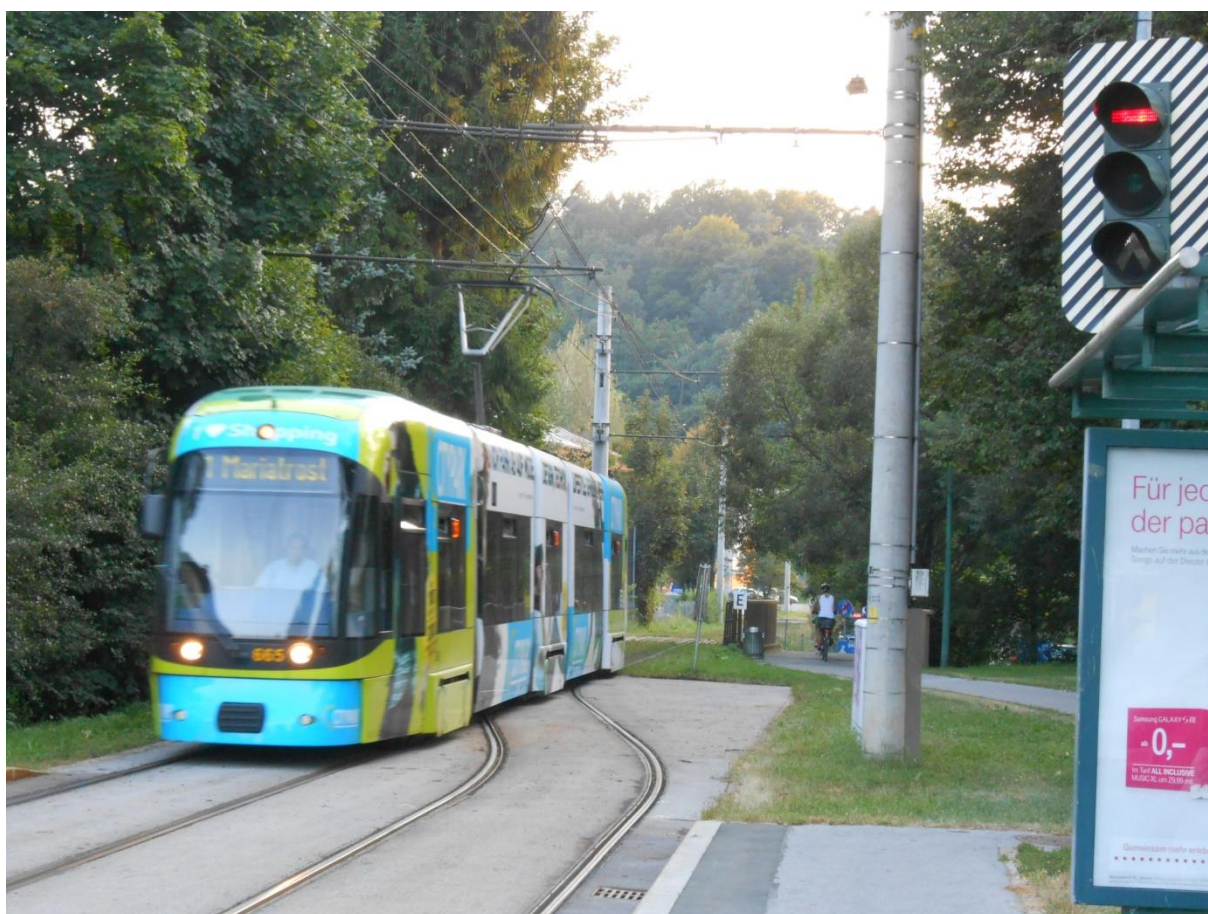
Obr.5 Výhybna na původní jednokolejně trati se zabezpečovacím zařízením, Graz, Mariatrost
