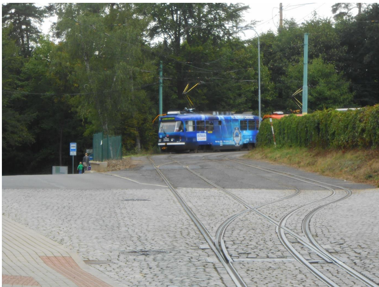
Obr.33 Smyčka s dvojím rozchodem v předjízdne koleji, Liberec-Lidové sady
