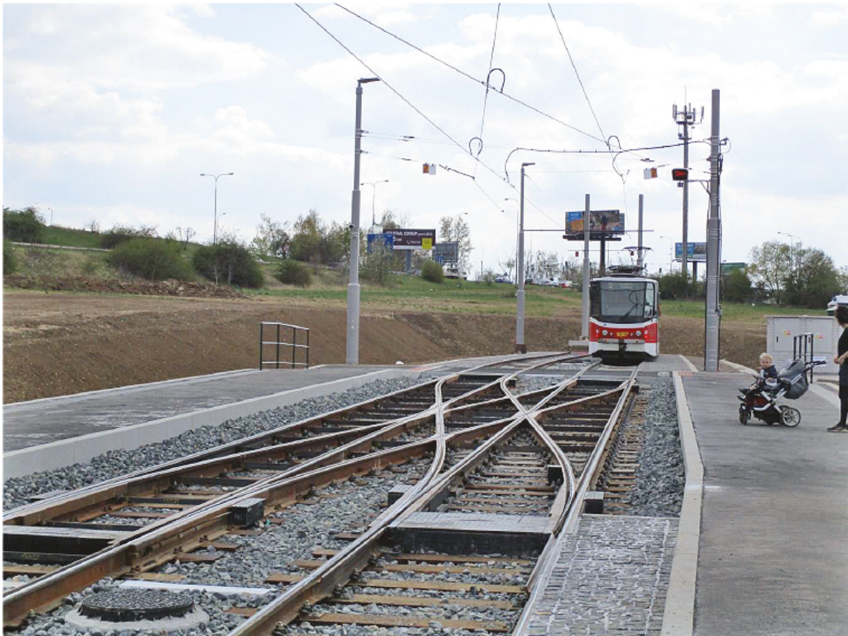
Obr.12 Kolejový přejezd se dvěma kolejovými spojkami, Praha-Holyně, dnes již přestavěno
