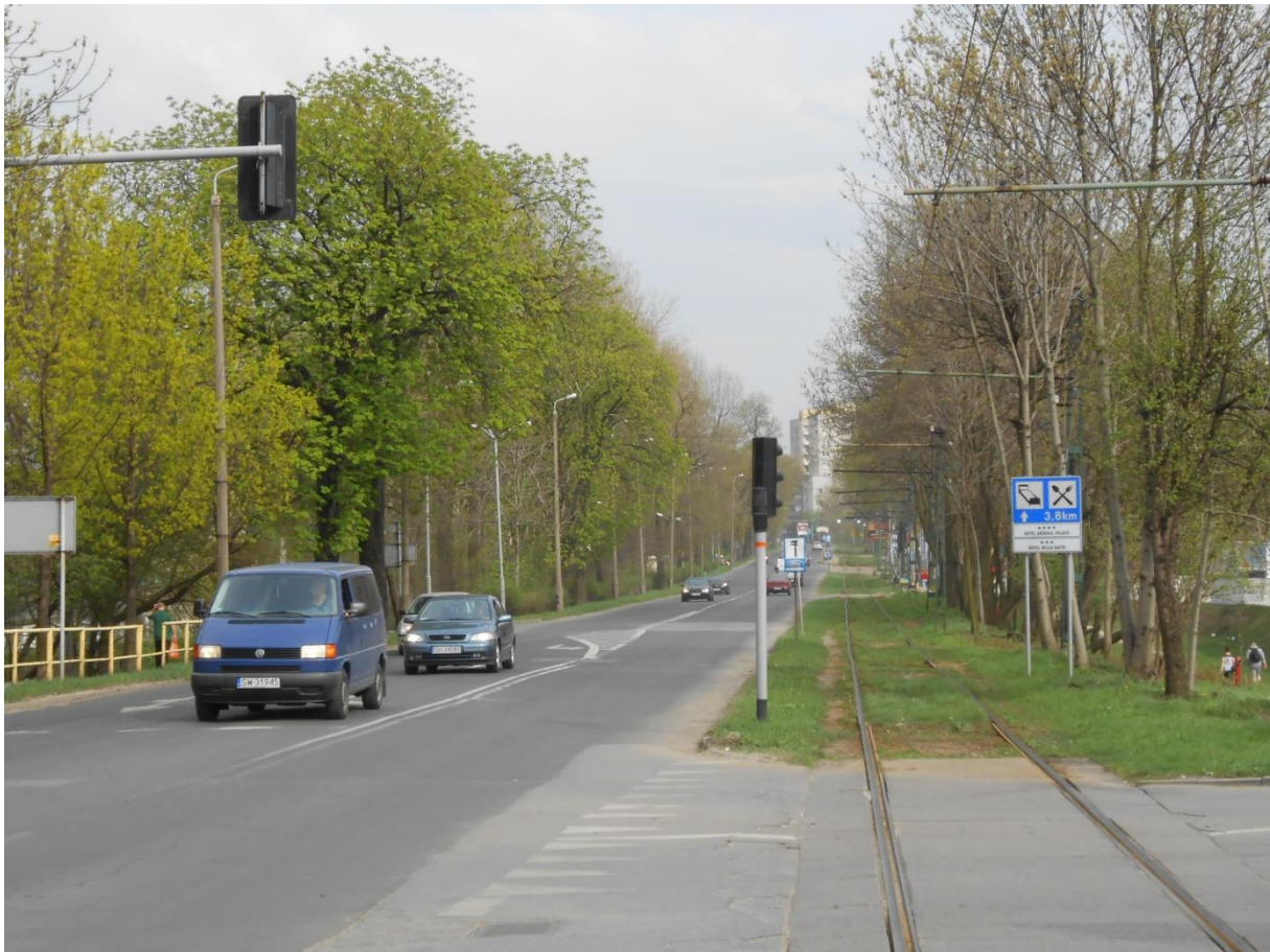
Obr.16 Typická trať typu interurbans, Katowice, Chorzów
