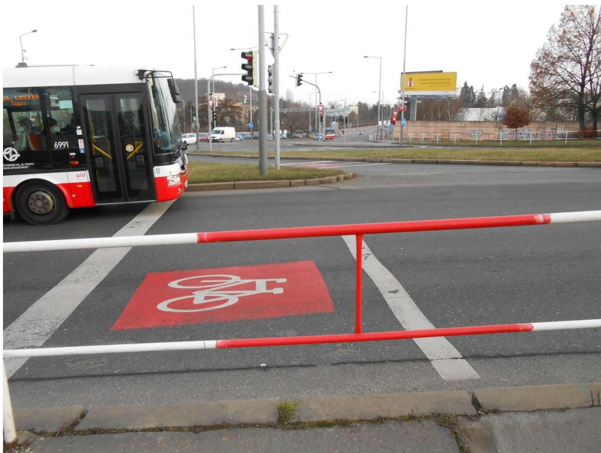
Obr. 5 Předsunutá stopčára - Praha, Vídeňská ulice (foto: autor, 2022)
