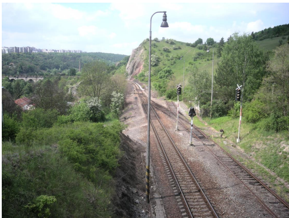
Obr. 4 Pražský Semmering, zastávka Žvahov (II.13)
