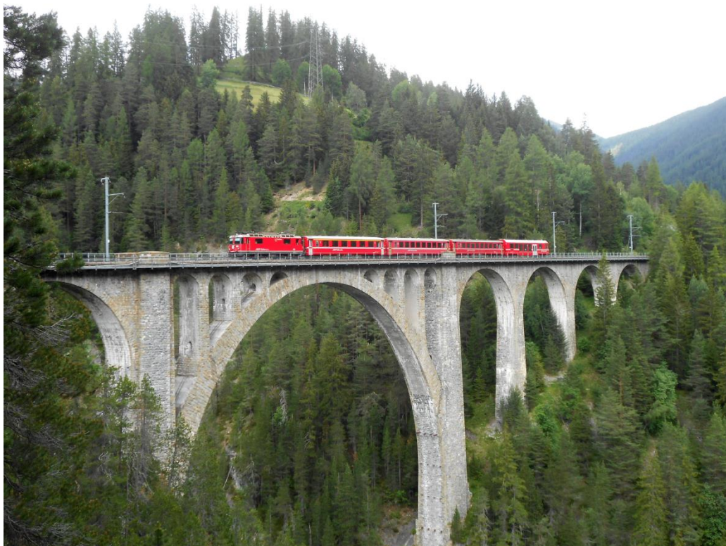
Obr. 20 Rhätische Bahn, viadukt Wiesen (VII.9)
