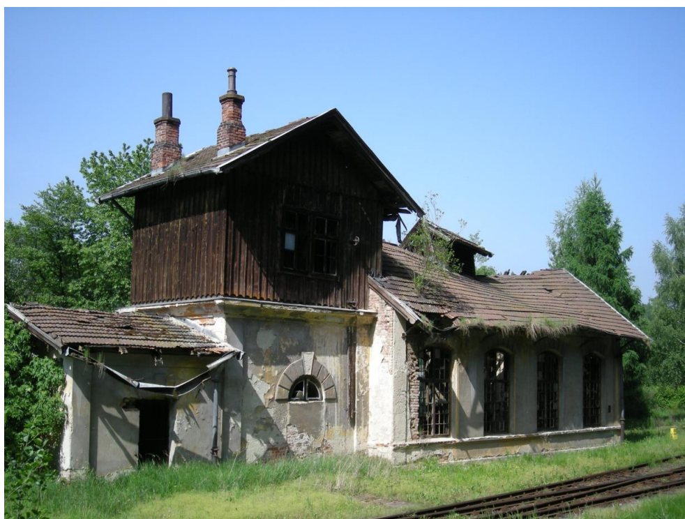
Obr. 6 Posázavský Pacifik, bývalá výtopna Leděčko (II.14)
