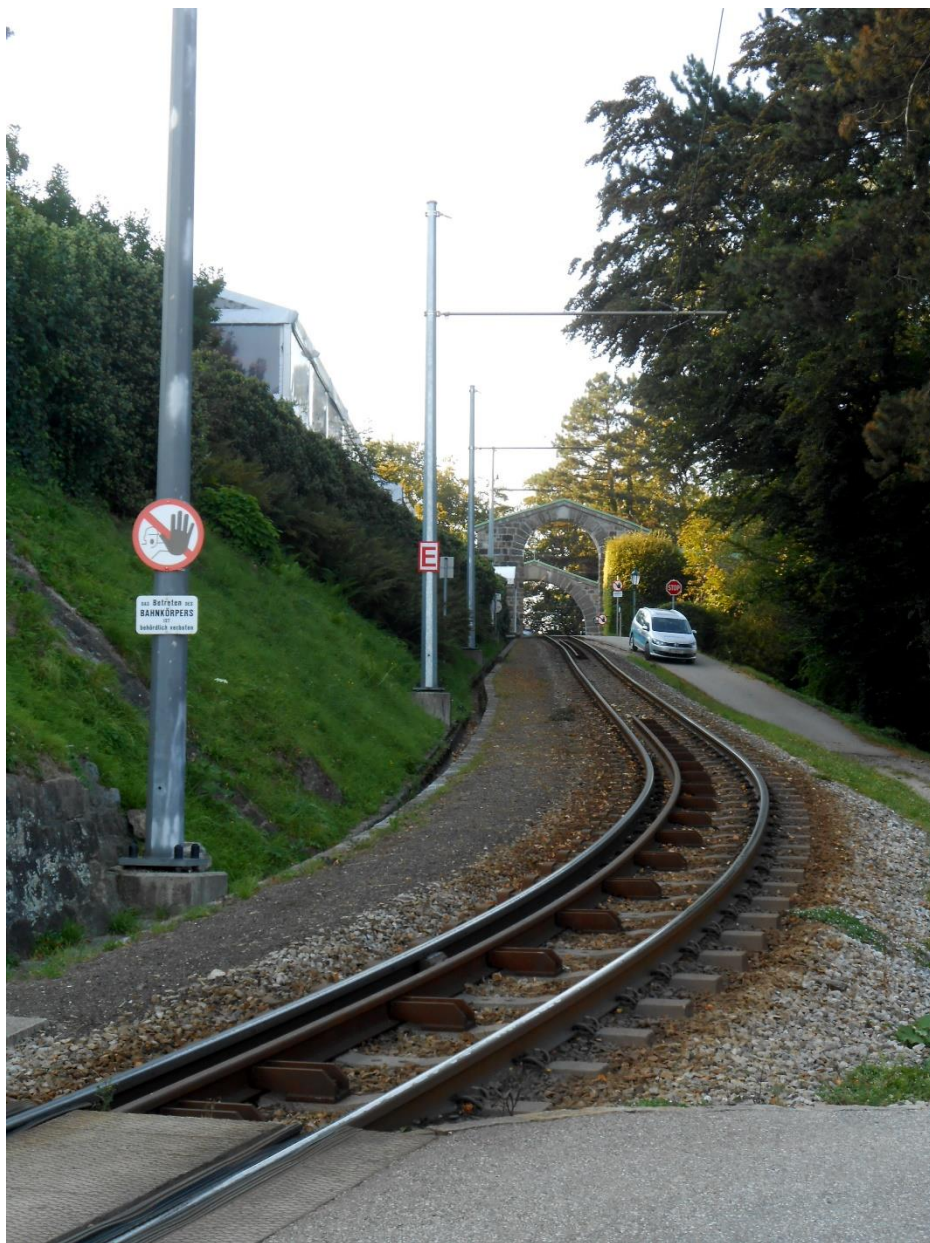
Obr. 52 Strmá trať pod vrcholem Pöstlingberg s přídržnou kolejnicí, Linz, Rakousko
