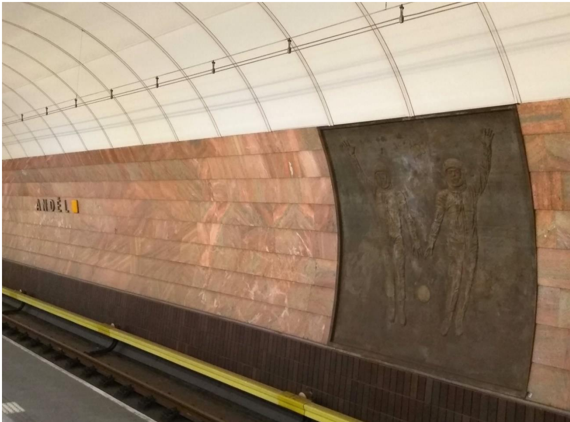
Obr. 26 Výzdoba ve stanici Anděl, v době otevření Moskevská (rok zprovoznění 1985), Praha
