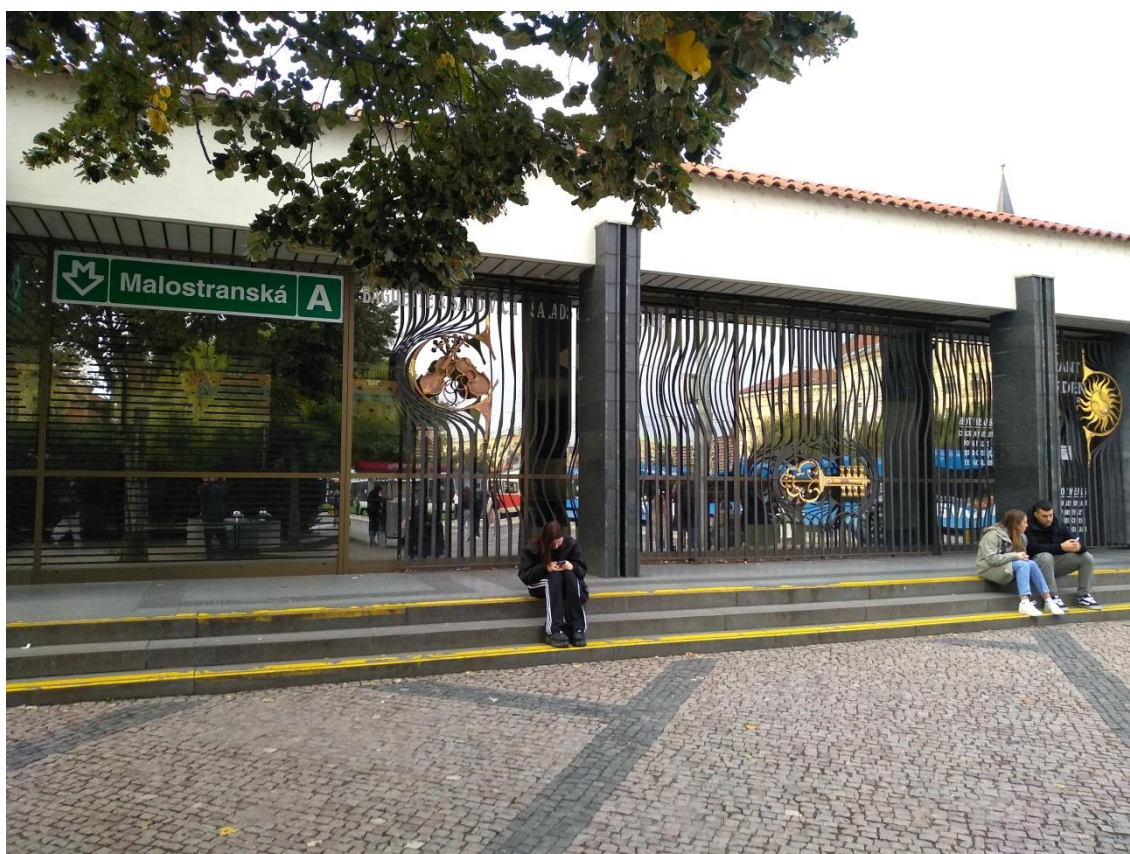
Obr. 23 Vstupní pavilon do stanice Malostranská (rok otevření 1978), Praha
