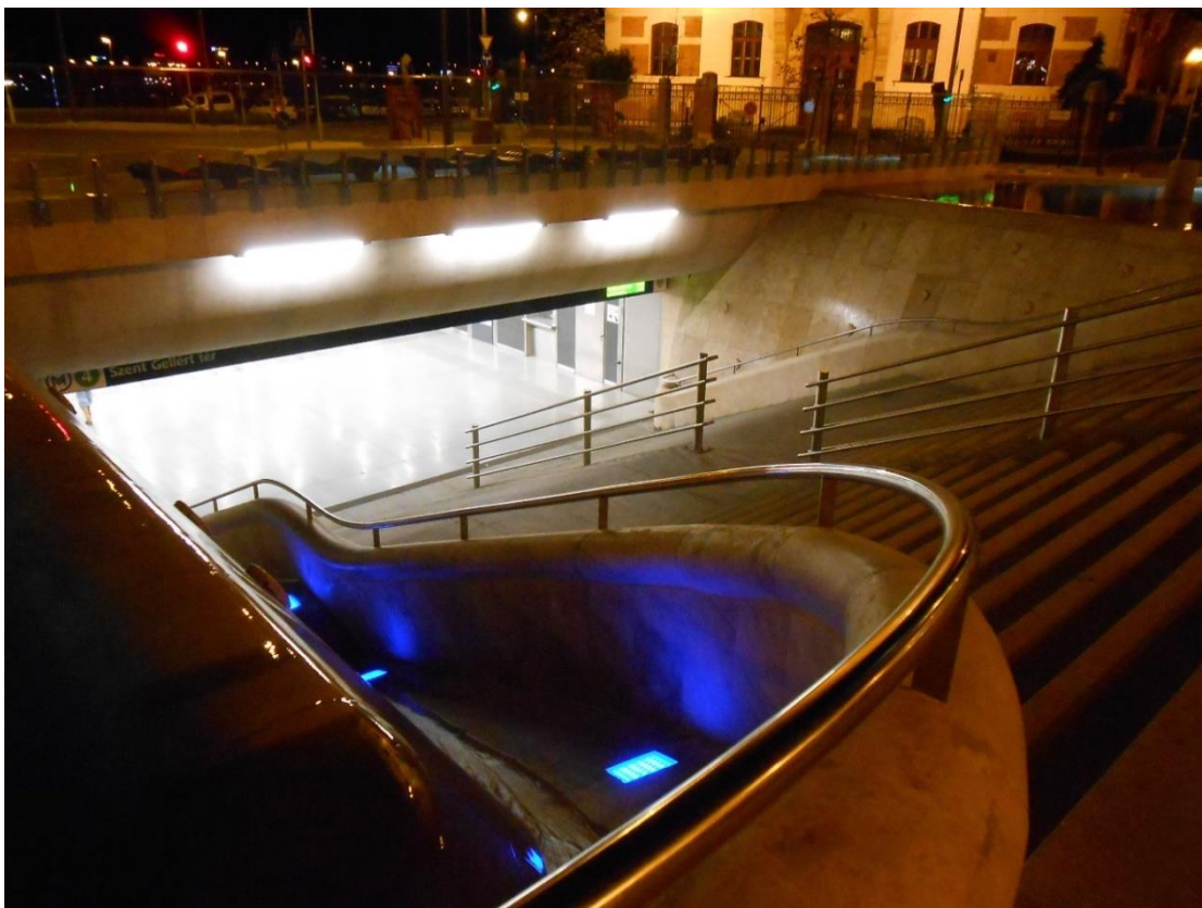
Obr. 35 Vstup do stanice Szent Gellért tér na lince M4, Budapešť, Maďarsko
