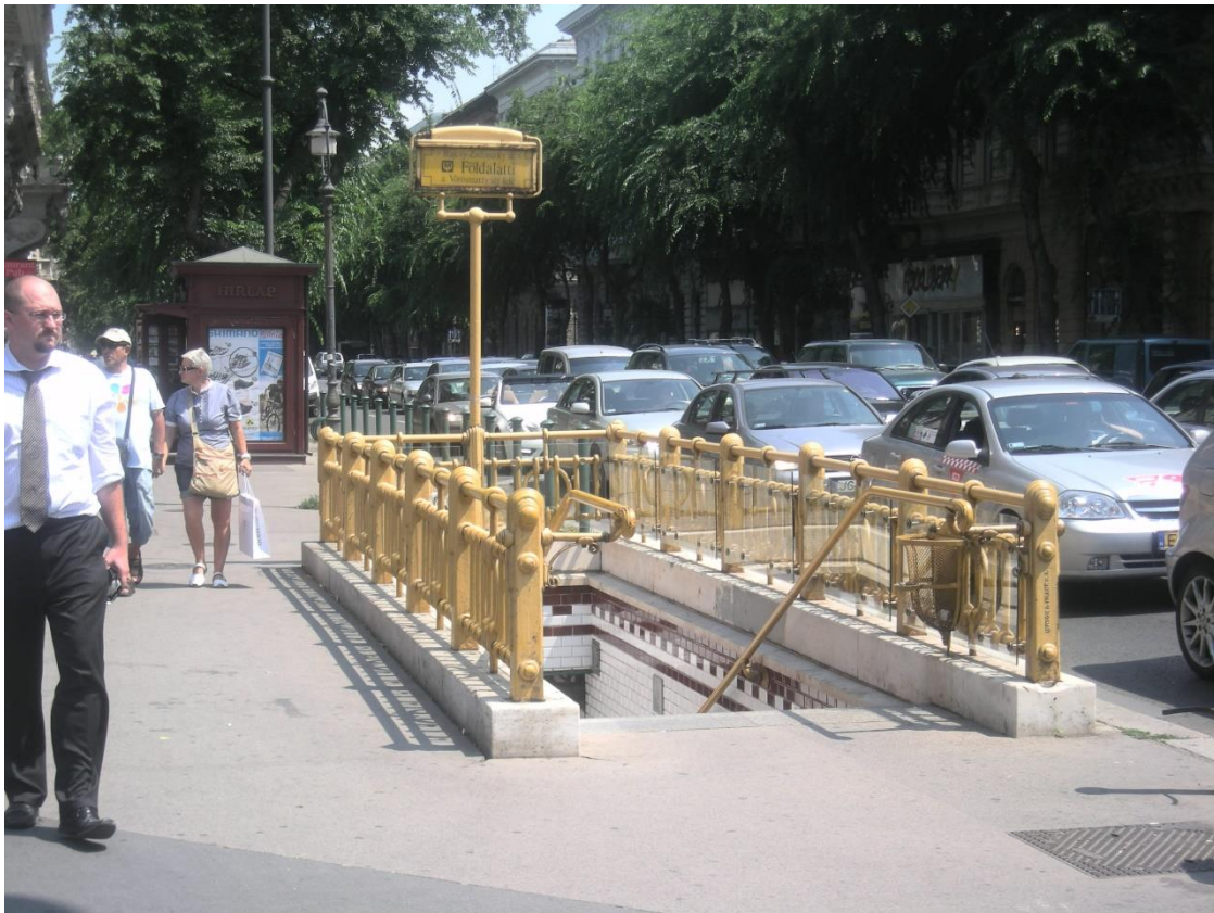
Obr. 34 Historický vstup do stanice Bajczy-Zsilinsky út na lince M1, Budapešť, Maďarsko
